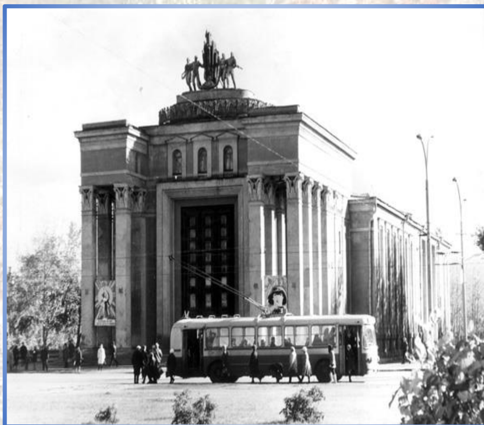
Здание киноконцертногозала Уральского алюминиевого завода (ДК УАЗа).
