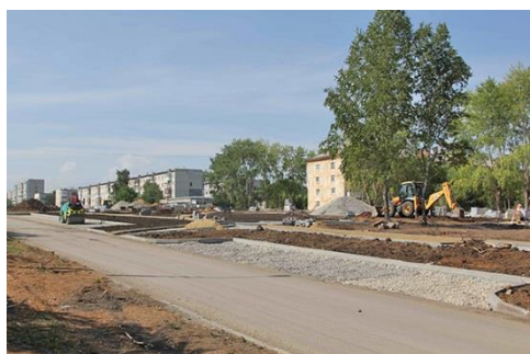
Фото 5. Вид реконструкции БПК (2020 год) (источник - интернет)
